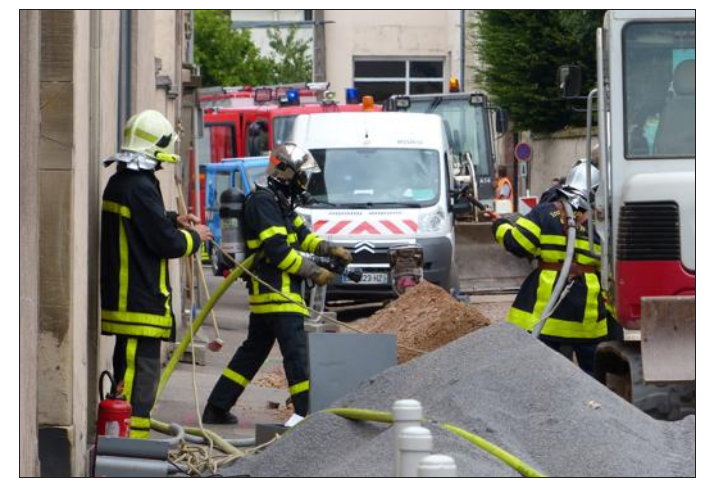
■ Les pompiers en protection pendant l'intervention de l'agent de GRDF.
